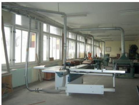
Слика 31. Систем за отпрашување
